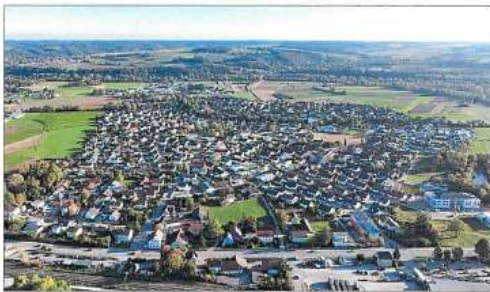
Ein Nahwärmenetz für Kronwieden auf einer Fläche von deutlich mehr als einem Quadratkilometer ist in der Diskussionsphase.
